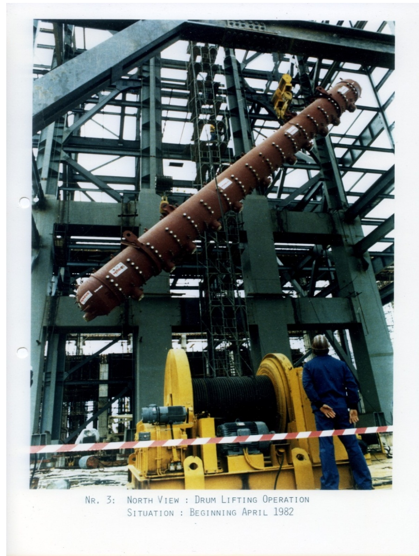
Central de Sines _ Elevação do barrilete _ 1982-04 _ FNI _ 12985 _ 23
