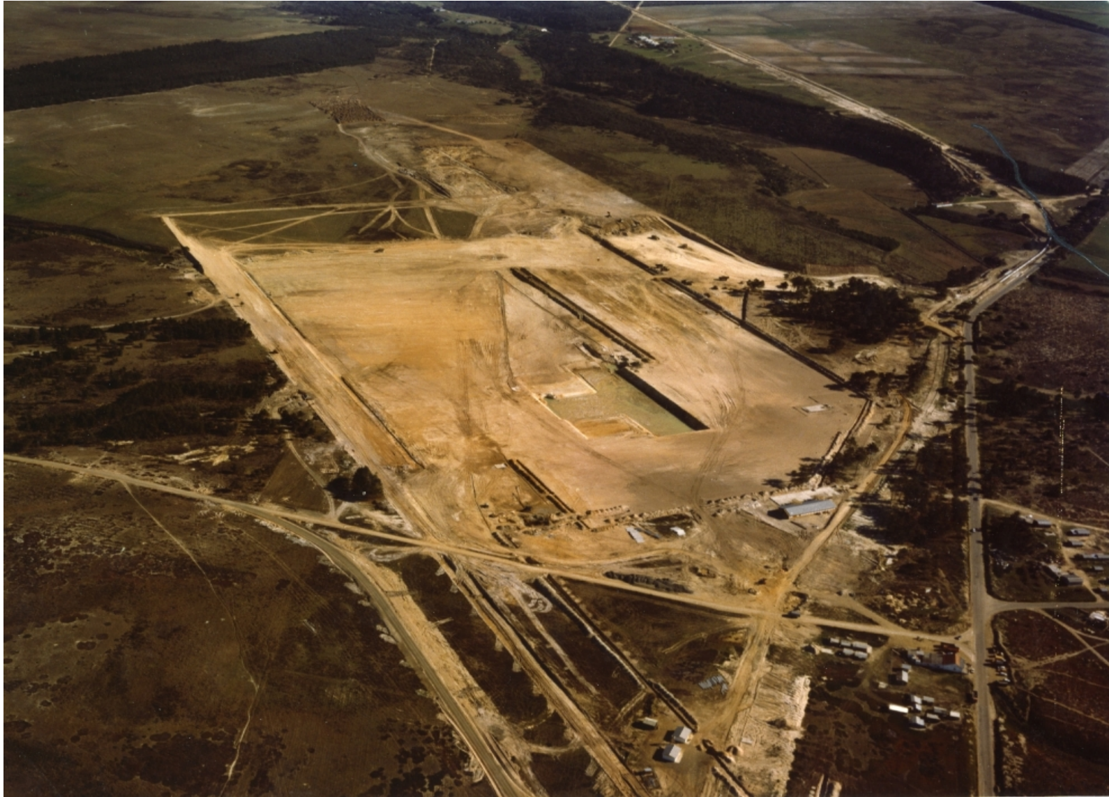
Central de Sines _ Vista aérea dos trabalhos de terraplanagem para construção _ 1980-12-26 _ FNI _ 12978 _ 46
