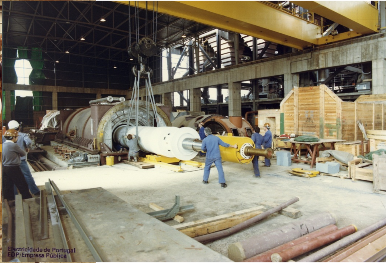
Central de Sines _ Turbo-alternador 1. Montagem do rotor do alternador _ 1983-11-24 _ FNI _ 13084 _ 1 e 3
