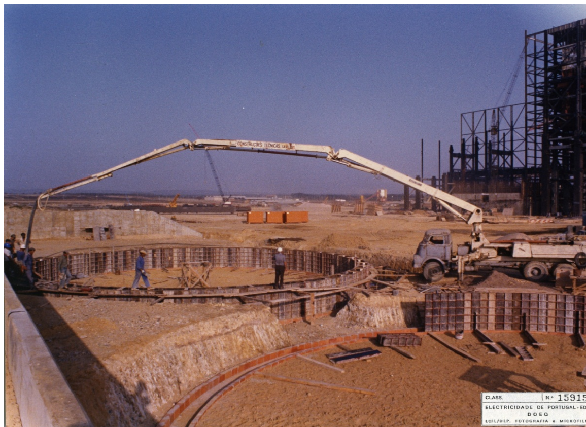
Central de Sines _ Tanques, montagem_ 1982-08-00 _ FNI _ 12938 _ 21
