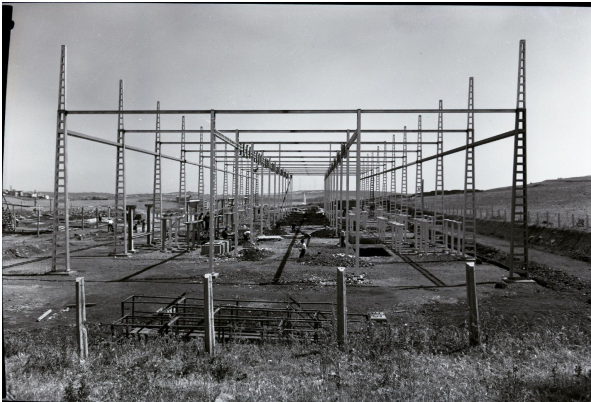
CRGE_Subestação de Carenque_1964_01_30_15384_269
