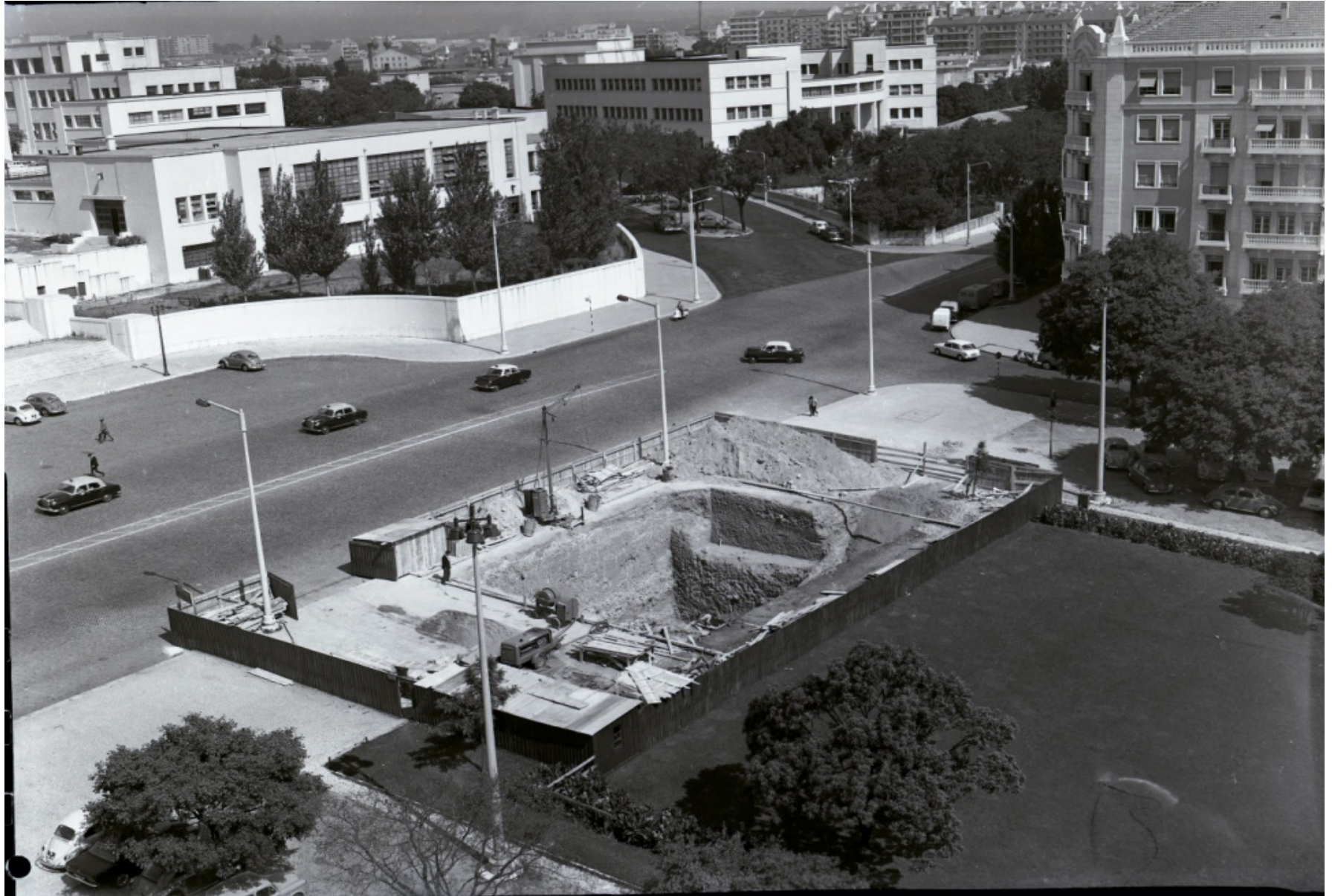
CRGE_Subestação da Alameda D.-Afonso-Henriques_1966_07_04_15384_028
